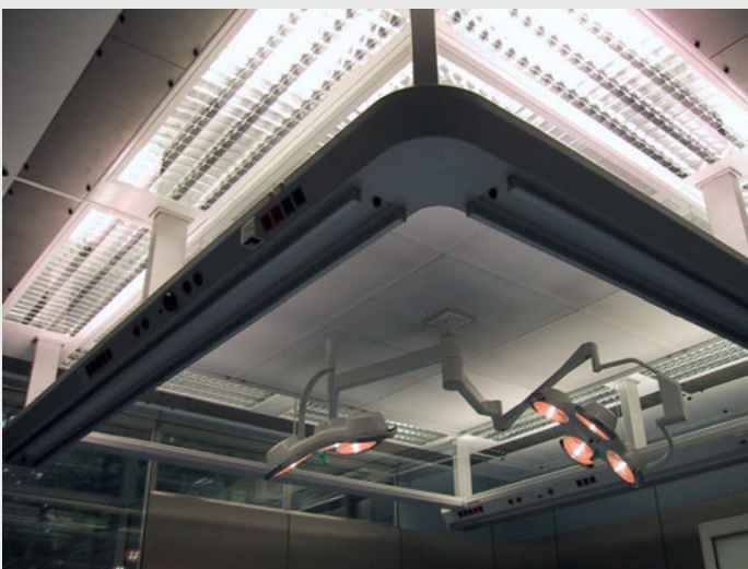
Приточный операционный потолок ROX для операционных, тип LCS.
