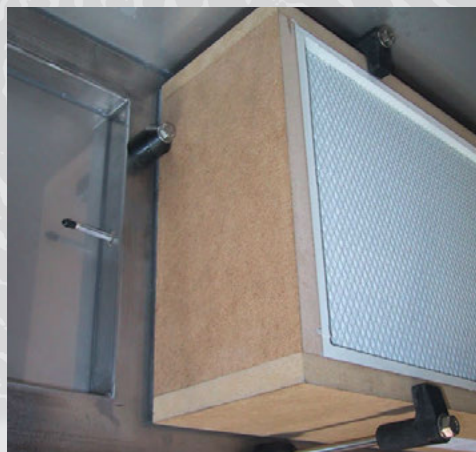
Монтаж фильтра с проверкой на герметичность посадки в типе LCS.
